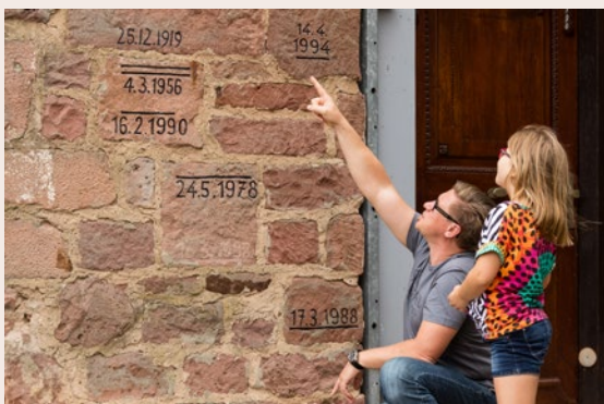
Beeindruckende Hochwassermarken an der Stadtmauer
