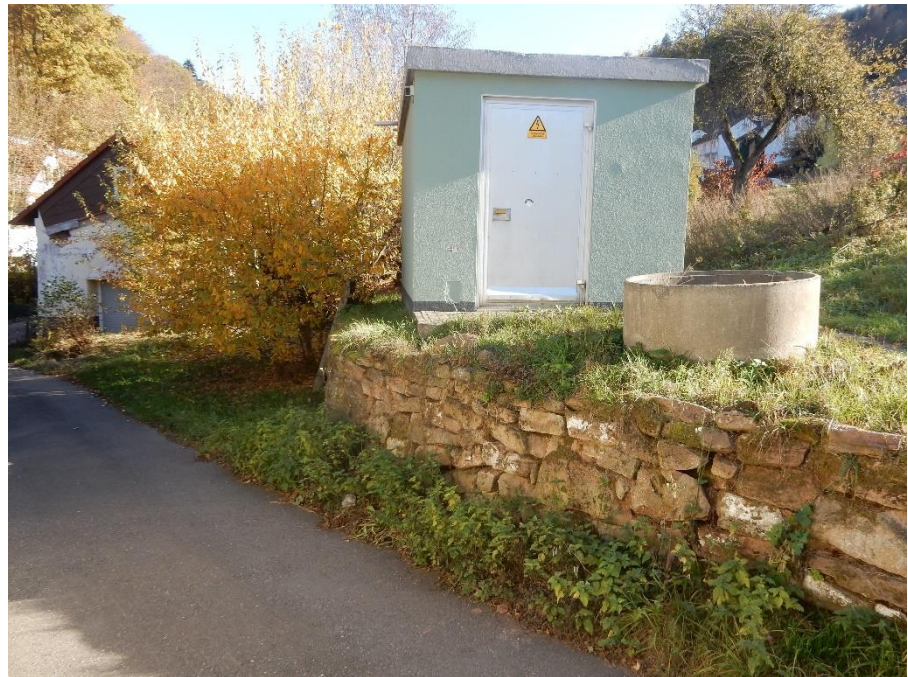
Foto 6: Trafohaus und Trockenmauer, im Hintergrund: Gebäudebestand
