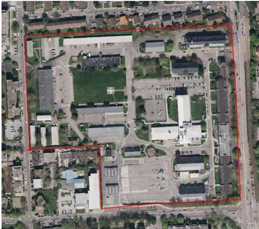
KLIMOPASS-Abschlussbericht „Planungsempfehlungen für die (stadt-)klimawandelgerechte Abb. 23: Die Konversionsfläche US Hospital im Luftbild (Luftbild Stadt Heidelberg)
