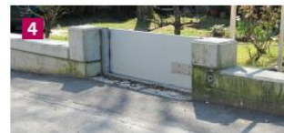
Schutz eines Grundstücks in Söllbach © Stadt Heidelberg
