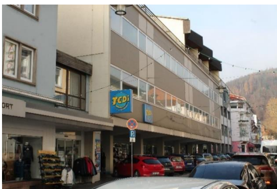
Abbildung 38: Modernisierungsbedarf und fehlende Fußgängerfreundlichkeit
