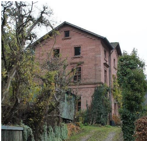
Abbildung 30: Am Bahnhof 5 Gaimühle - Ehem. Bahnhof (Quelle: WHS, 2019)
