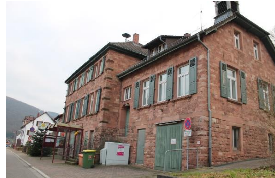
Abbildung 23: Ehemaliges Rat- und Schulhaus (Quelle: WHS, 2019)
