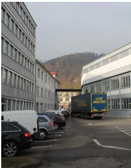
Abbildung 32: Engstelle Turnplatz Richtung Norden (Quelle: WHS, 2019)
