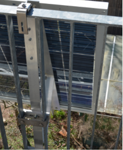
Beispiel: Montagedreieck für offene Geländer
