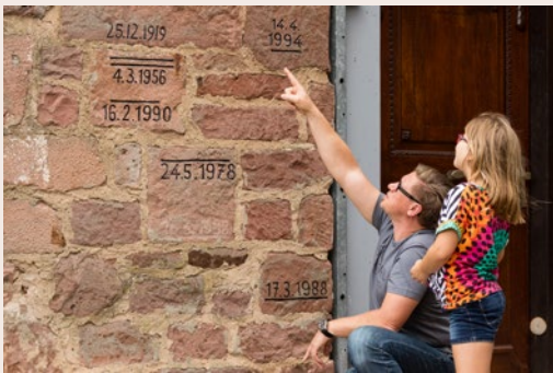
Beeindruckende Hochwassermarken an der Stadtmauer
