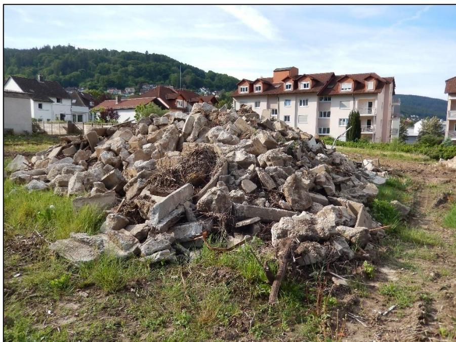
Foto 2: Ein aus Sandstein gemauerter Keller ist nahezu vollständig abgerissen und ausgehoben worden, der Bau- schutt wurde ebenfalls auf der Fläche angehäuft.
